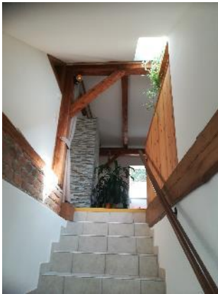
Zugang in den Dachboden
